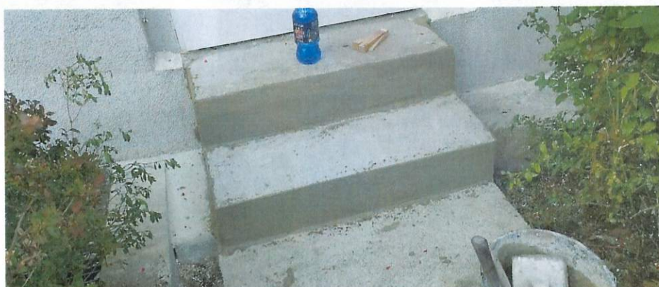
1.9. Wykonanie drzwi tylnych wraz ze schodami zewnętrznymi w lokalu użytkowym przy ul. Wyszyńskiego 3 – Centrum Terapii Esti
