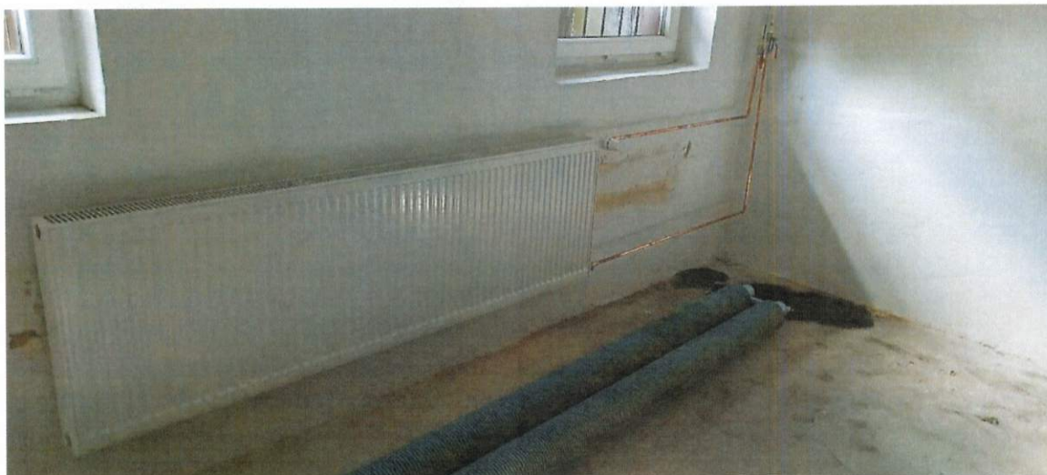
6.1. Wymiana starego grzejnika typu favier na nowy w pomieszczeniu gospodarczym suszarni.
