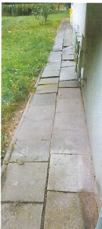
5.2. Wymiana zniszczonej opaski wokół budynku.
