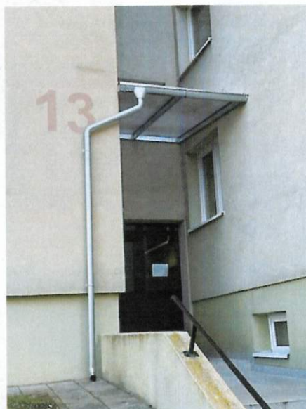
3.4. Nowe zadaszenie nad wejściem tylnym do budynku.
