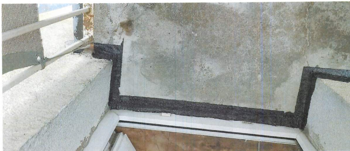
7.5. Naprawa płyty balkonowej 11B/8 i 10.
