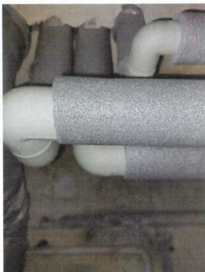
7.3. Prace awaryjne związane z wymianą pionów zimnej, ciepłej wody i cyrkulacji w klatce 11A,C,F.
