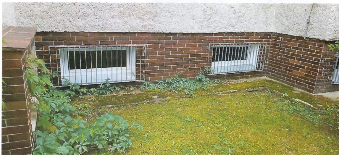
7.4. Renowacja ościeży, parapetów i krat okienek piwnicznych budynku.
