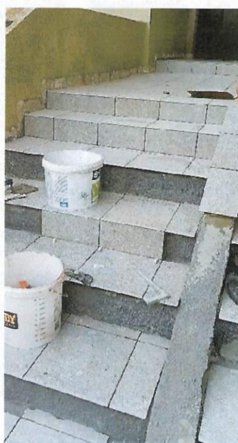
3.1. Położenie nowych płytek na tylnych schodach zewnętrznych.
