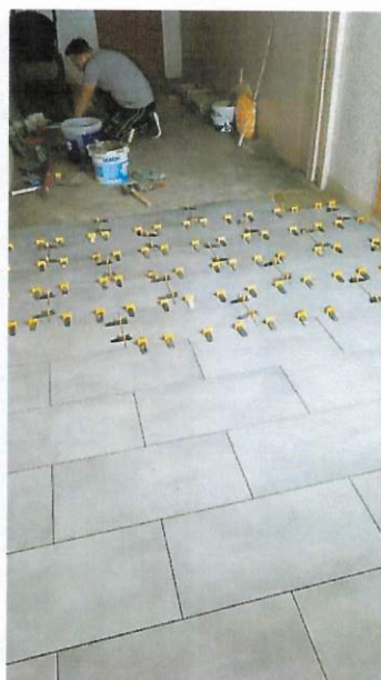
5.1. Położenie płytek na schodach do piwnicy, poziomie zerowym, schodach na parter i poziomie parteru klatki schodowej.
