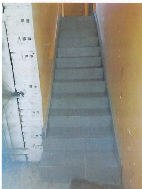
1.4. Wyłożenie płytek na schodach zejściowych do piwnicy Wyszyńskiego 3.
