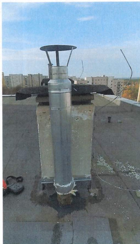
3.2. Wymiana skorodowanego kominka wentylacyjnego oraz miejscowa naprawa pokrycia dachu.
