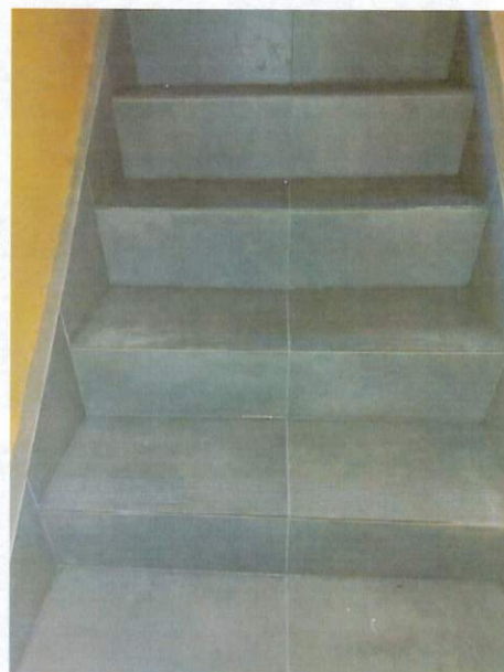
1.4. Wyłożenie płytek na schodach zejściowych do piwnicy Wyszyńskiego 3.
