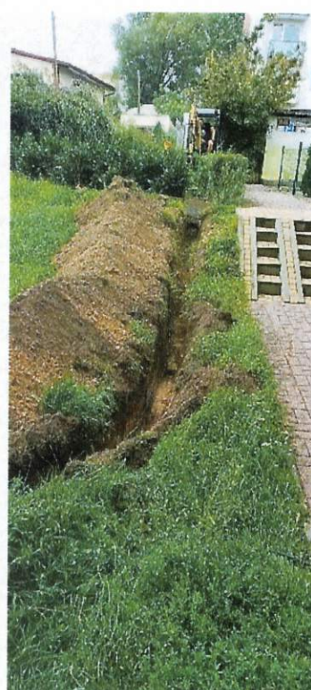
2.4. Doprowadzenie instalacji elektrycznej do pergoli śmietnikowej, w celu montażu elektronicznego systemu zamykania drzwi.
