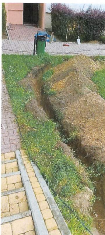
2.4. Doprowadzenie instalacji elektrycznej do pergoli śmietnikowej, w celu montażu elektronicznego systemu zamykania drzwi.
