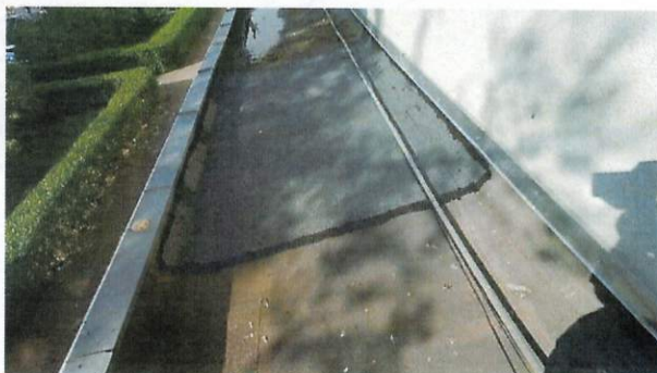
1.10. Uszczelnienie pokrycia dachowego nad lokalem użytkowym – apteką.
