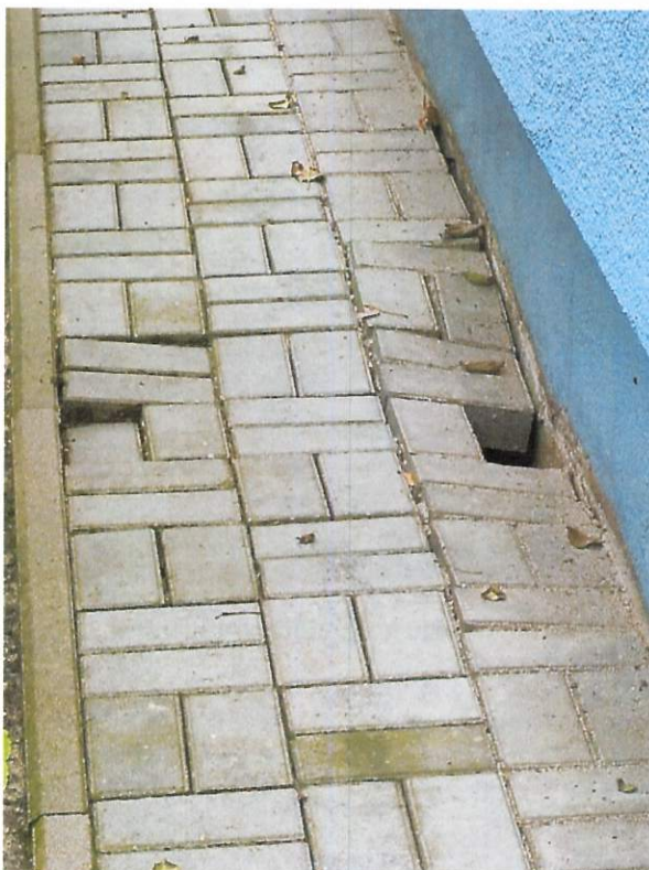
6.3. Miejscowa naprawa opaski budynku między klatkami 81 a 79, uszkodzenie spowodowane migracją szczurów.
