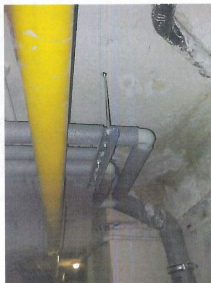
7.3. Prace awaryjne związane z wymianą pionów zimnej, ciepłej wody i cyrkulacji w klatce 11A,C,F.
