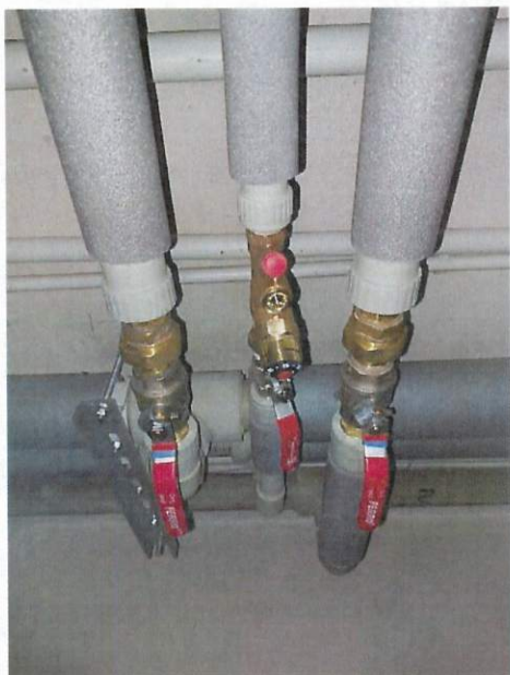
7.1. Wymiana zaworów podpionowych w piwnicy budynku.
