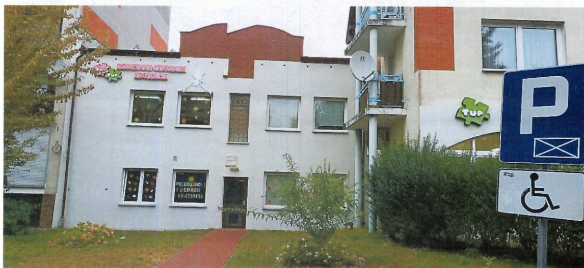
9.2. Naprawa i malowanie elewacji budynku przedszkola przy ul. Strumykowej 15J.
