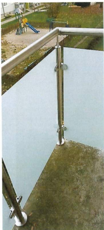
1.12. Wymiana barierek balkonów w części mieszkań budynku przy ul. Wyszyńskiego 1-11 oraz ul. Wypoczynek 17-22.
