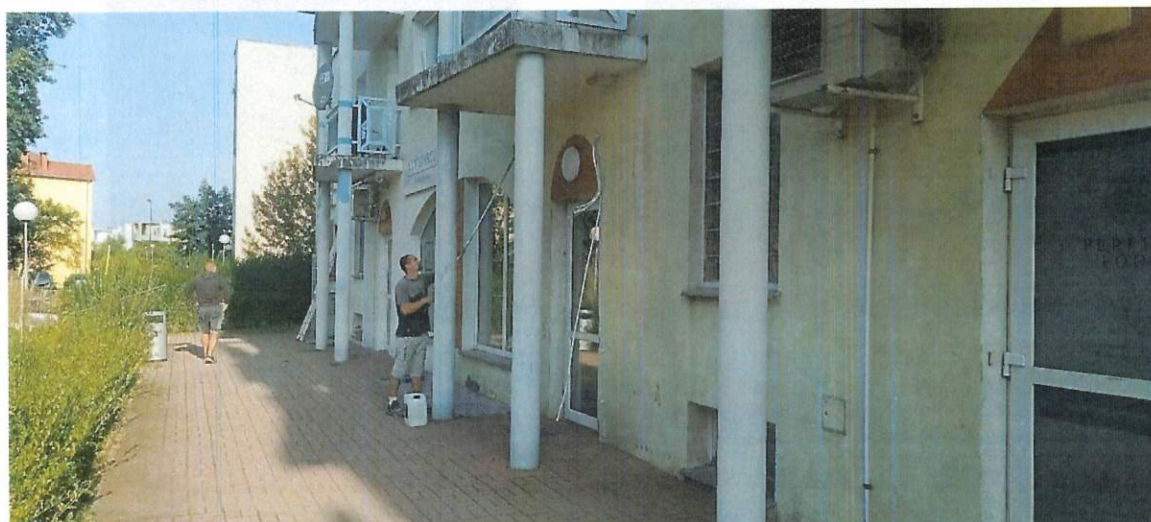
9.1. Naprawa i malowanie elewacji lokali użytkowych pasażu handlowego.
