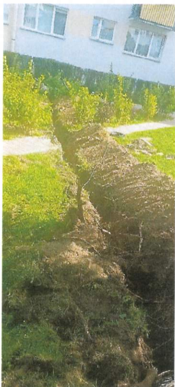
2.4. Doprowadzenie instalacji elektrycznej do pergoli śmietnikowej, w celu montażu elektronicznego systemu zamykania drzwi.
