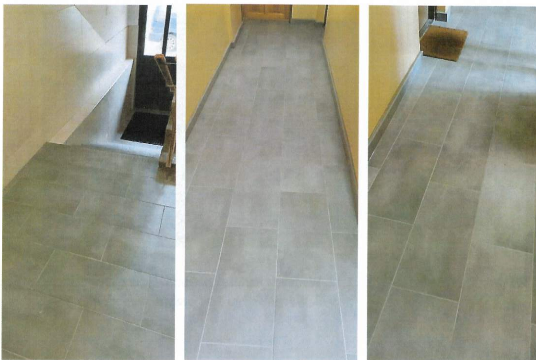
2.1. Położenie płytek na schodach do piwnicy oraz na poziomie zero, schodach wejściowych na parter i poziomie parteru we wszystkich klatkach budynku przy ul. Wypoczynek 17-22.
