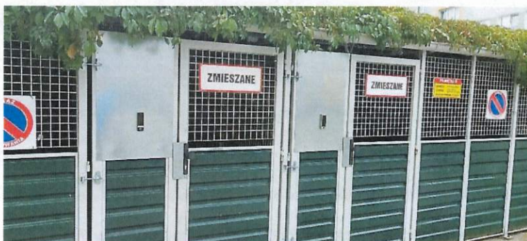
1.11. Zamontowano elektroniczny system otwierania pergoli śmietnikowej przy budynku ul. Wyszyńskiego 1-11 oraz ul. Wypoczynek 17-22.
