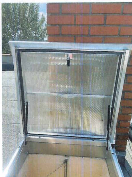
9.3. Montaż nowego wyłazu dachowego. Wyjście na dach z klatki 15L
