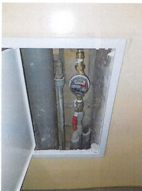
2.2. Usunięcie piecyka gazowego w lokalu mieszkalnym ul. Wypoczynek 21/28 i podłączenie instalacji do miejskiej sieci ciepłej wody.
